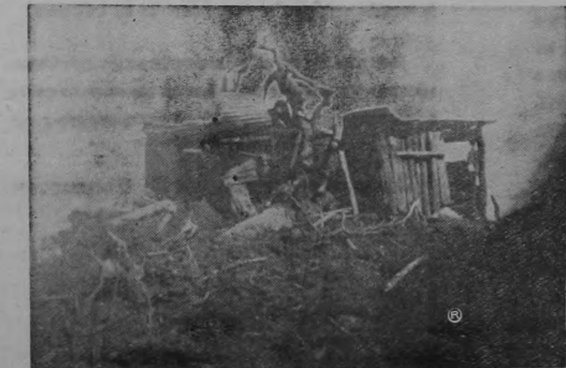
PEQUENA vivienda semidestruída al producir- se la bomba de agua que arrasó con la residen- cia del Sr. Romero, que estaba inmediata.
